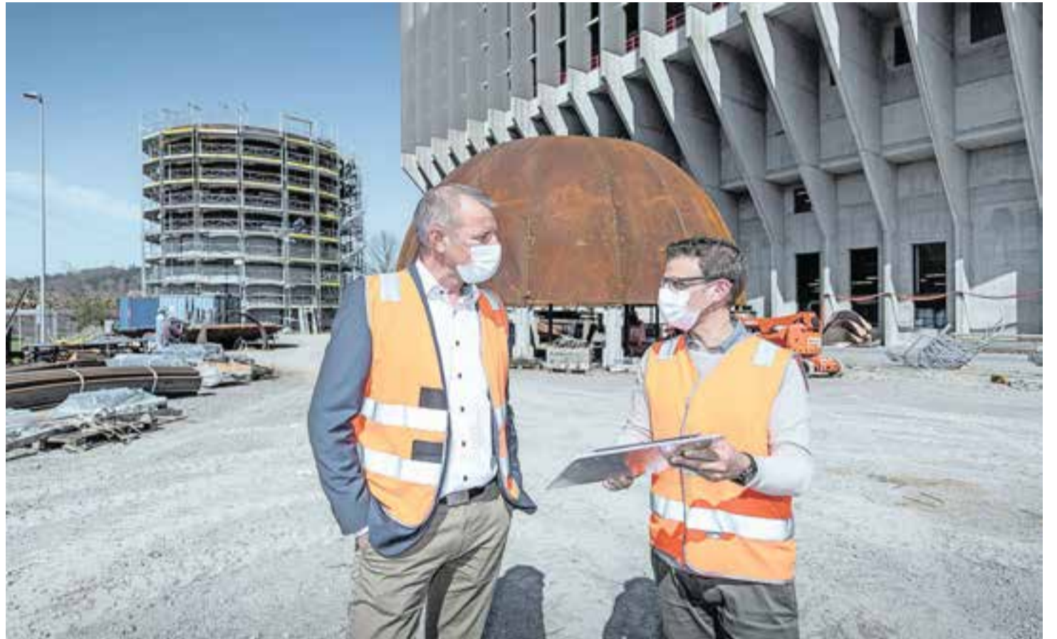
Ruedi Kummer (links) und Claudio Helbling vor dem neuen Wärmespeicher.
