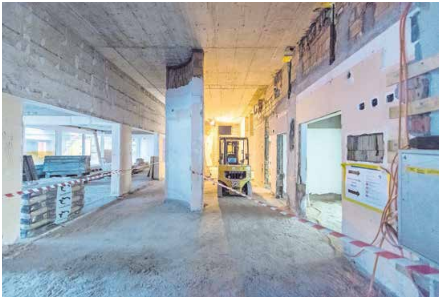
Das ehemalige Hotel Flora in Vitznau, das zu einem Gastro- und Musik-Kompetenzzentrum umgebaut wird. Bild: Plus Amrein (8. Dezember 2019)
