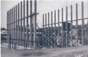
Der Turnhallenflügel der KSS entsteht.
